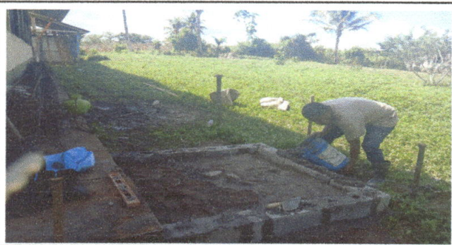
Foto 5: Se observa la construcción de la base del tinaco.
