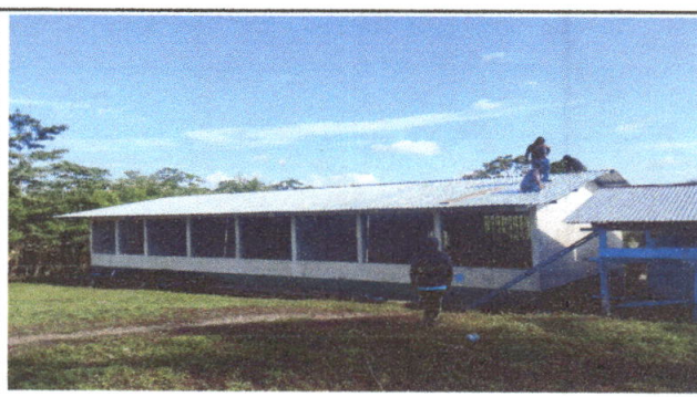
Foto 4: Se observa la culminación del techado de la escuela.
