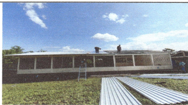
Foto 3: Se observa la colocación de las láminas.
