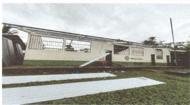
Foto 1: Se observa la colocación de las costaneras
